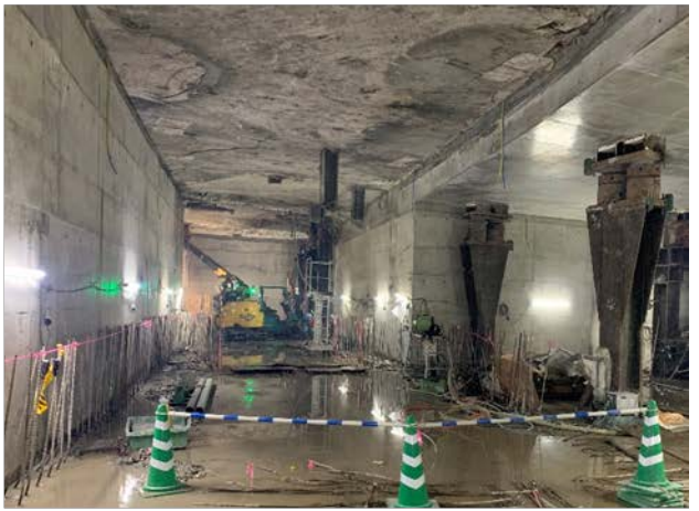
④駅舎部の構築状況 (空港線軌道下部：地下4階)
