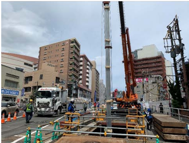
③電線路工事の電車線路搬入状況 (地上部より)
