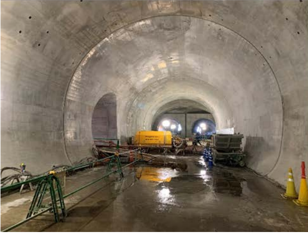
③トンネル構築状況 (標準トンネルI型部)
