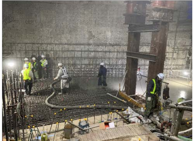
④駅舎部の構築状況 (連絡通路部：地下4階上床)
