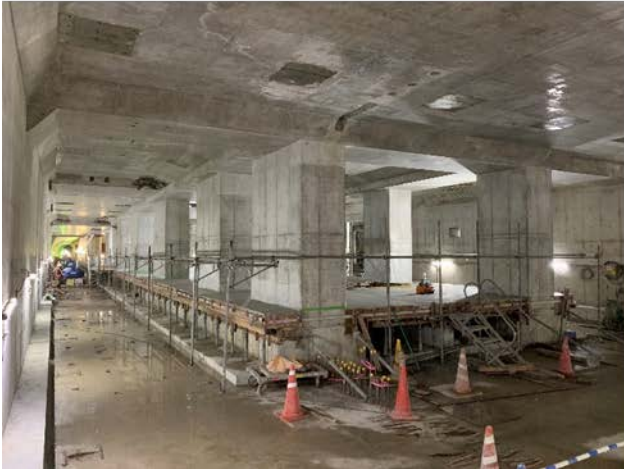
③駅舎部の構築状況 (JR地下街下部：地下5階プラットフォーム)
