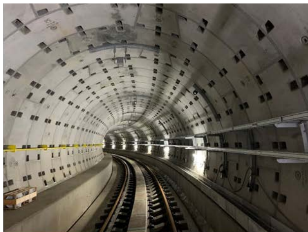
②電線路工事の進捗状況 (西行線・トンネル内)
