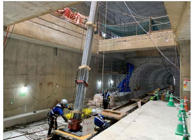
④電線路工事の電車線路搬入状況 (地下部より)
