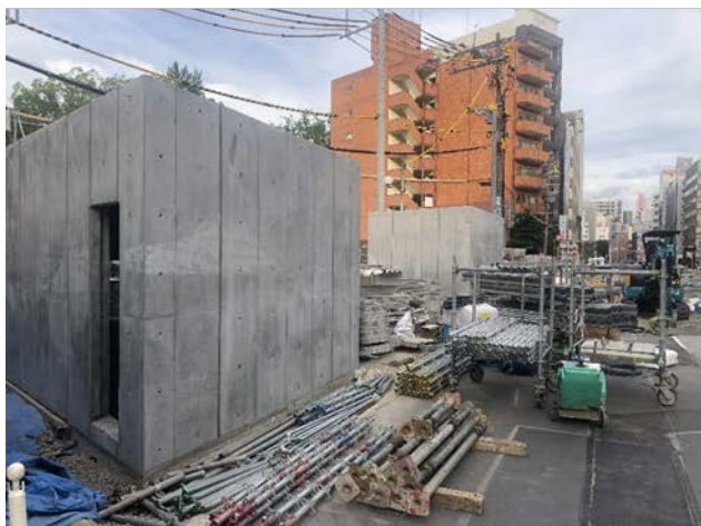
③建築工事の進捗状況 (換気塔部)
