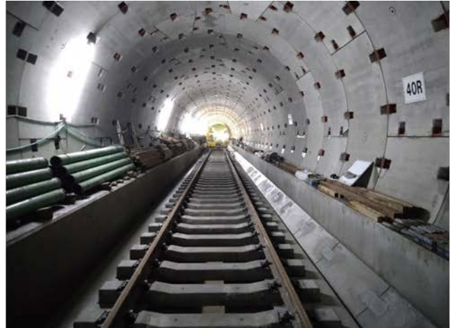
④電線路工事の電車線路搬入状況 (地下部より)
