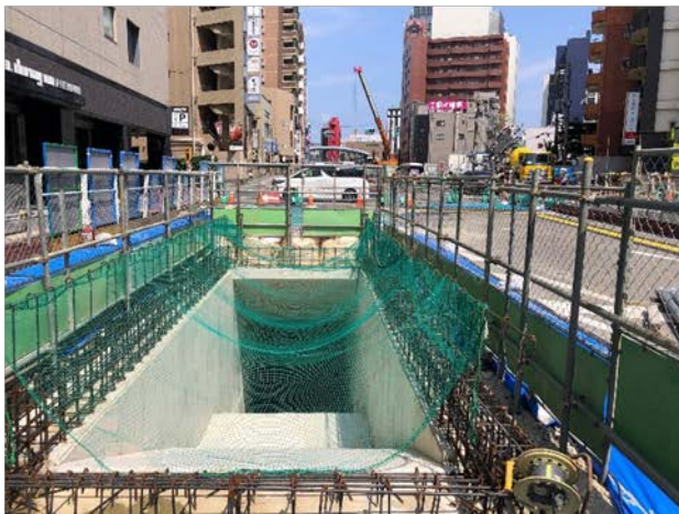
③駅出入口の構築完了（土木工事） （博多駅側出入口・階段部）
