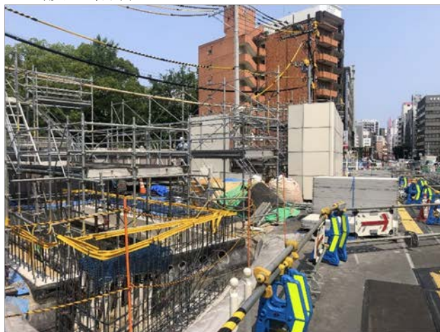
④建築工事の進捗状況 （換気塔部）
