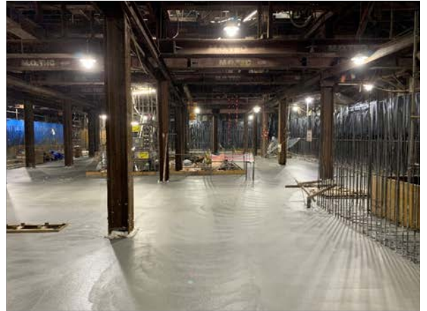
②駅舎部の構築状況 （北側開削部：地下3階）
