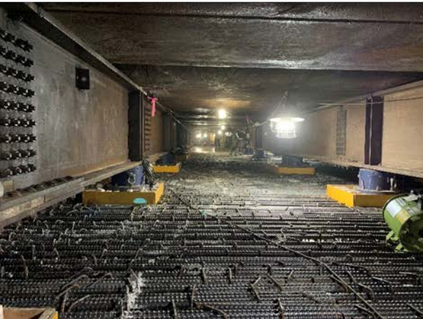
③駅舎部の構築状況 （パイプルーフ部：地下4階上床）
