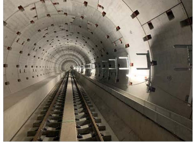
②軌道工事・電線路工事の進捗状況 （東行線・トンネル内）
