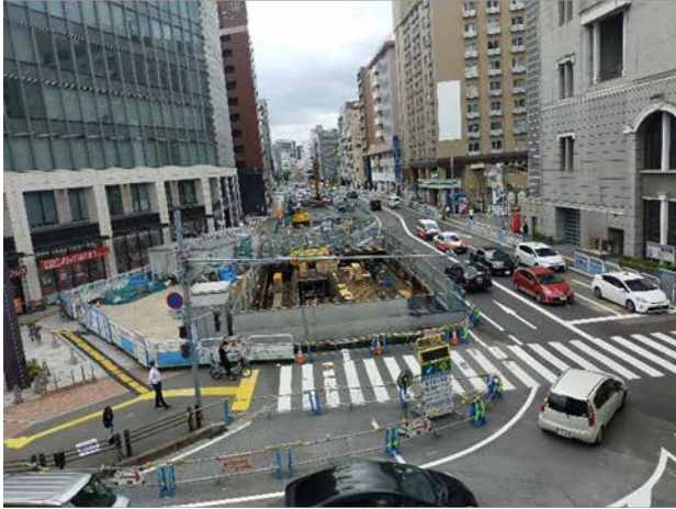
③駅出入口の構築状況（その1） （中洲川端側出入口：階段部）
