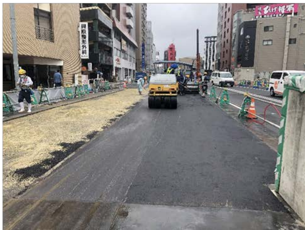
④道路復旧の状況（舗装） （地上部）
