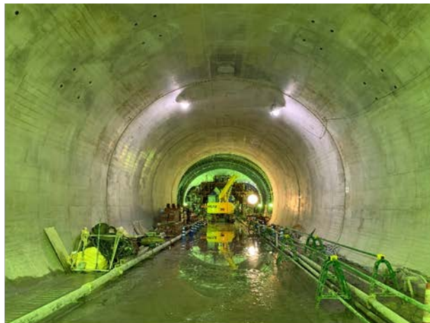
④トンネル構築状況 （3連トンネル部左右坑）
