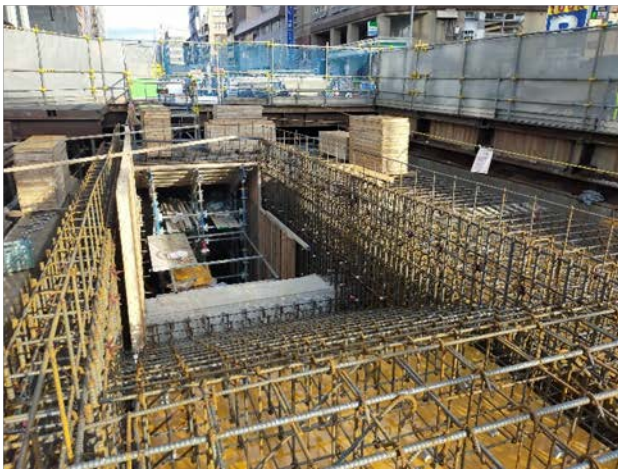
③駅出入口の構築状況（その1） （中洲川端側出入口：階段部）
