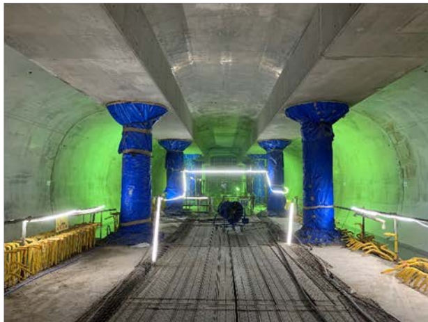
④トンネル構築状況 （3連トンネル部左右坑）
