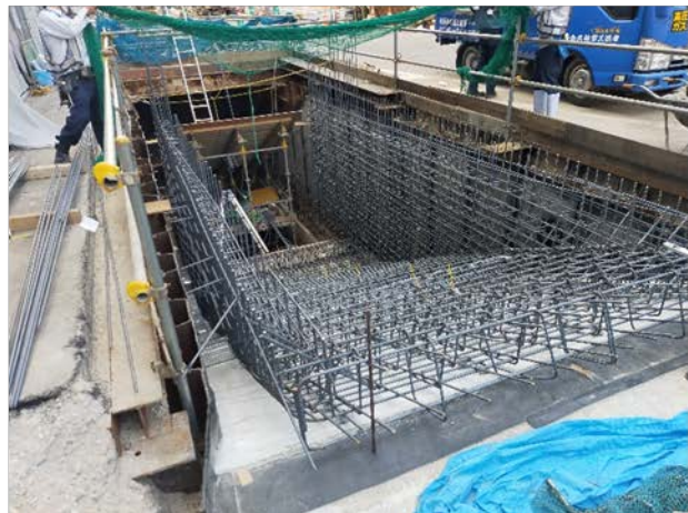
③駅出入口の構築状況 （博多駅側出入口・階段部）
