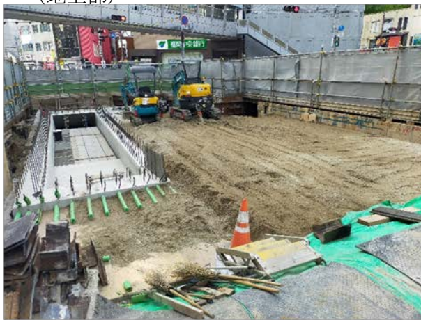
④道路復旧の状況（埋戻し） （地上部）
