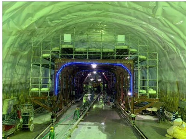
③トンネル構築状況 （標準トンネル II 型部）
