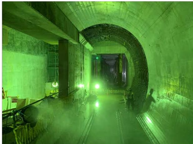
④トンネル構築状況 （3連トンネル部右坑）
