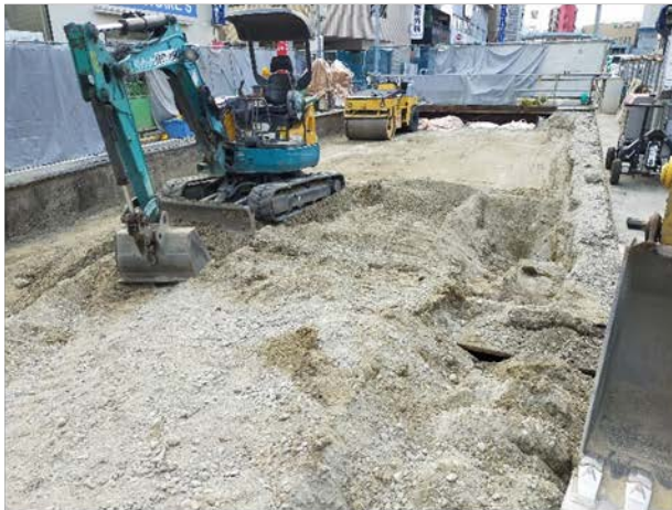
④道路復旧の状況（埋戻し） （地上部）
