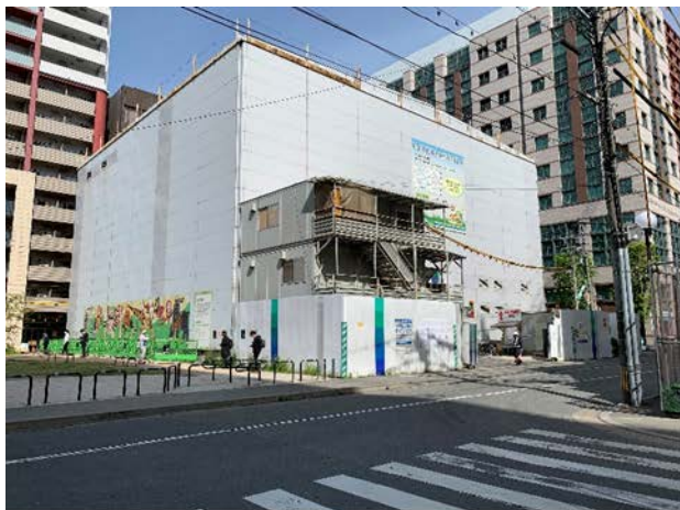
①防音ハウス （明治公園内）
