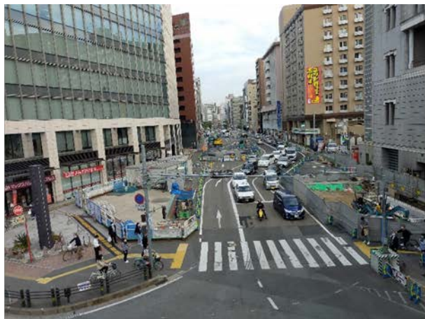
①はかた駅前通りの占用状況 （祇園町西交差点より）
