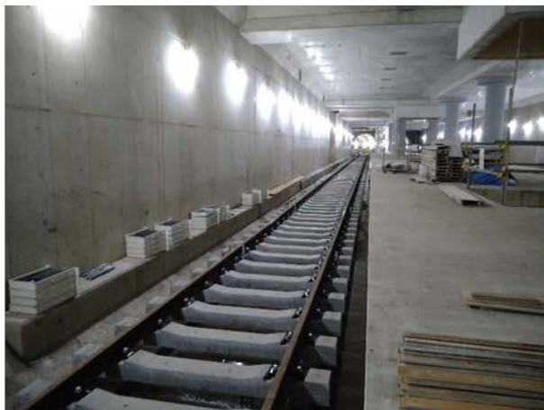
②軌道工事の進捗状況 （駅舎部・地下4階）
