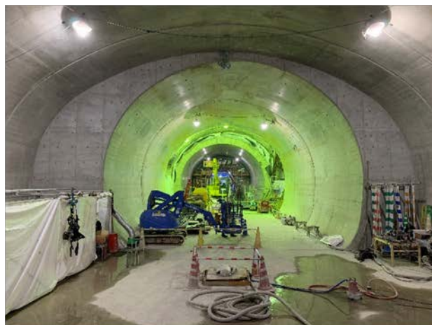
②トンネル構築状況 （標準トンネル I 型部）
