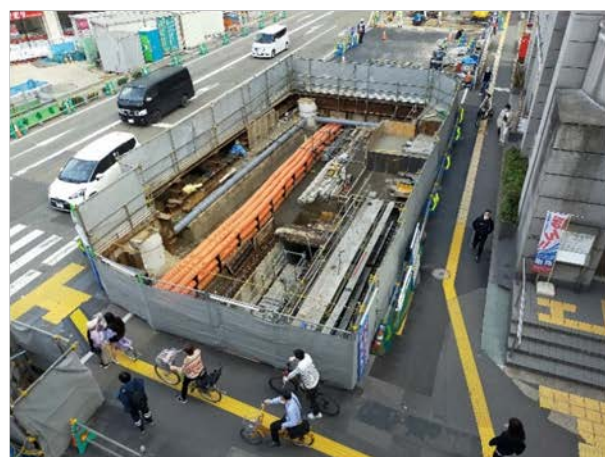
④駅出入口の構築状況 （中洲川端側出入口：エスカレーター部）
