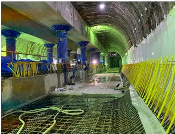
3連トンネル部のトンネル掘削が完了し、ナトム区間におけるトンネル掘削は全て完了となりました。
