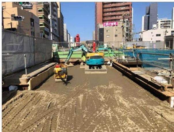
中間駅（仮称）と博多駅（仮称）間のトンネル区間では、トンネル内の構築が全て完了しました。駅舎部では、プラットホームや階段の構築が完了し、引き続き、駅出入口の躯体構築や道路復旧等を進めています。
