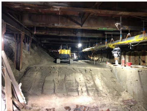
②道路の埋戻し状況 （駅舎部～地上部間）
