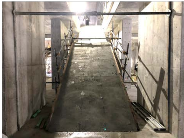
④階段の構築状況 （駅舎部・地下4階）
