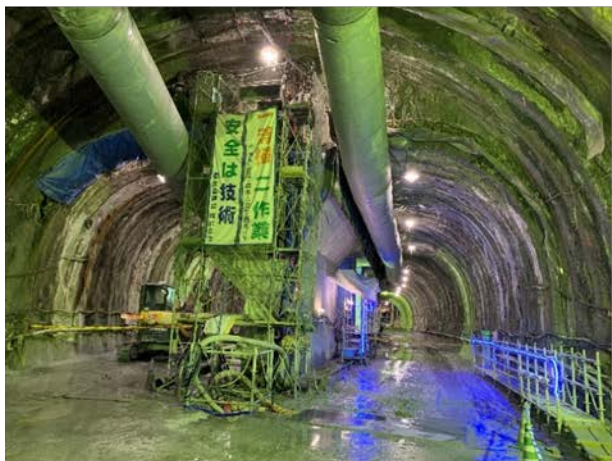
③トンネル掘削状況（左右坑） （3連トンネル部）
