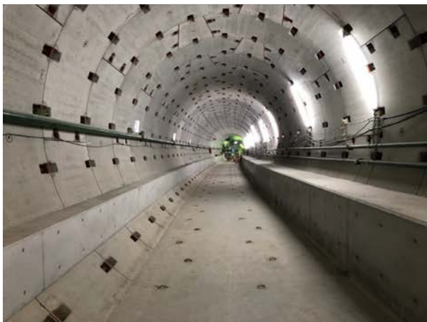
③トンネル内の構築状況 （東行線・トンネル内）
