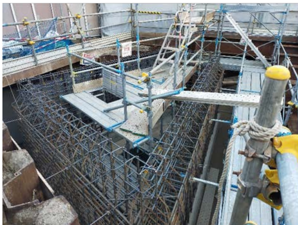
③換気塔の躯体構築状況 （地上立ち上がり部）
