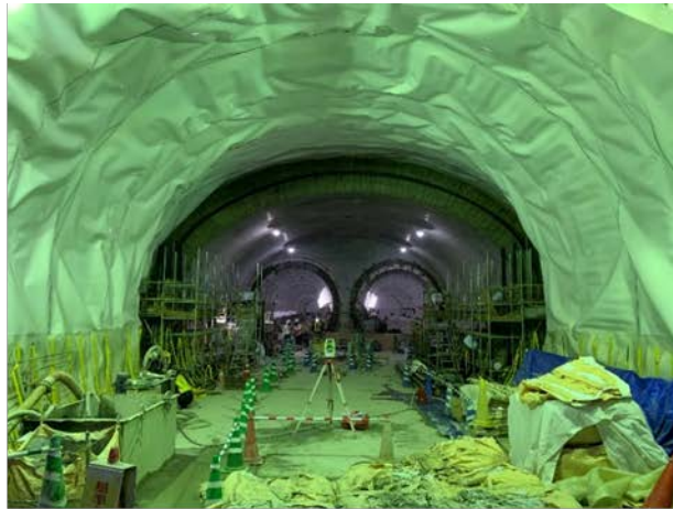
②防水シートの設置状況 （標準トンネル I 型部）
