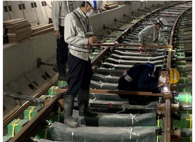
②軌道工事の進捗状況 （東行線・トンネル内）
