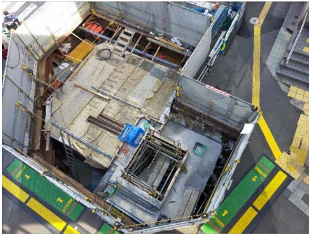
③駅出入口の構築状況 （中洲川端側出入口・エレベーター部）
