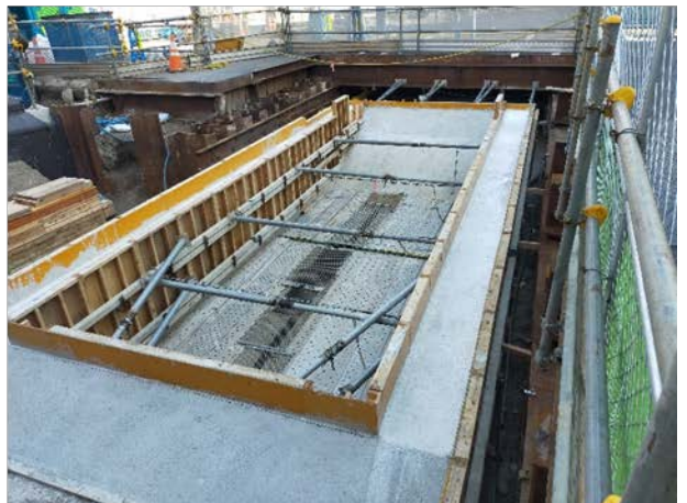
④駅出入口の構築状況 （駅中央部出入口・階段部）
