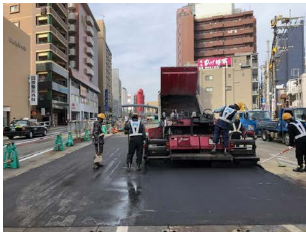
②道路の埋戻し状況 （地上部・車線規制帯内）
