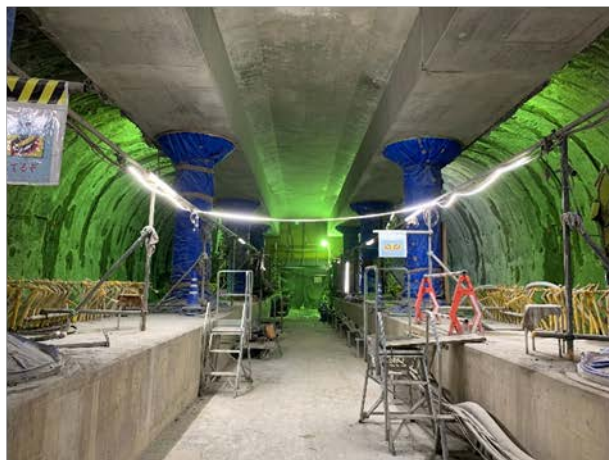
④トンネル掘削状況（左右坑） （3連トンネル部）
