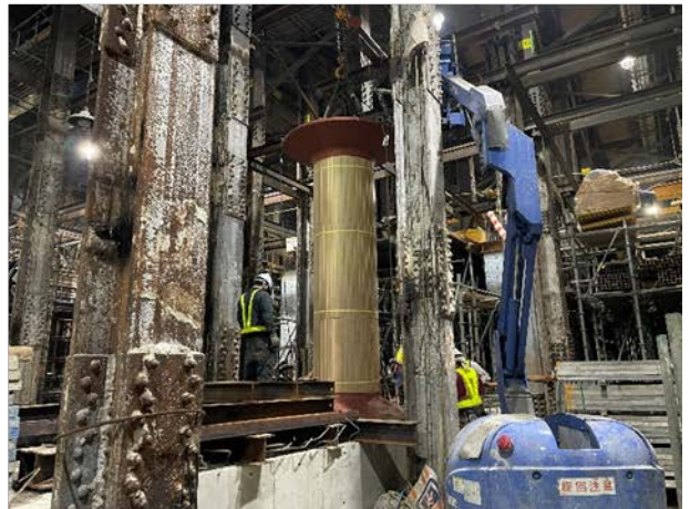
④駅舎部の構築状況 （JR地下街部：地下5階）
