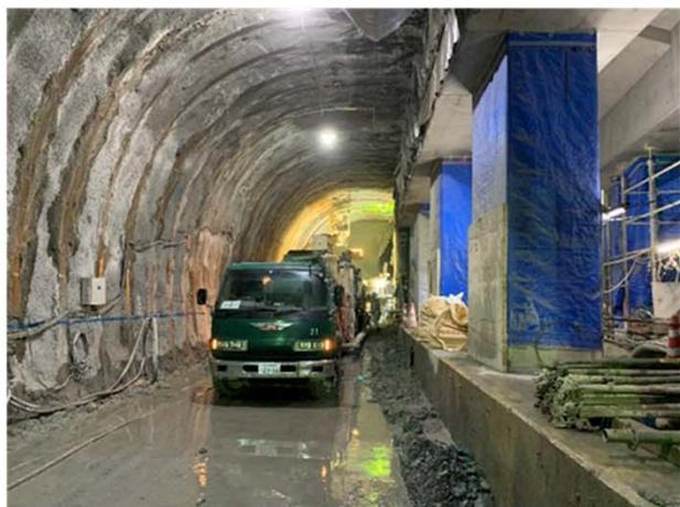
3連トンネル部(左右坑)では、縦パイプルーフ【※】の施工やトンネルの掘削工事を実施しています。
