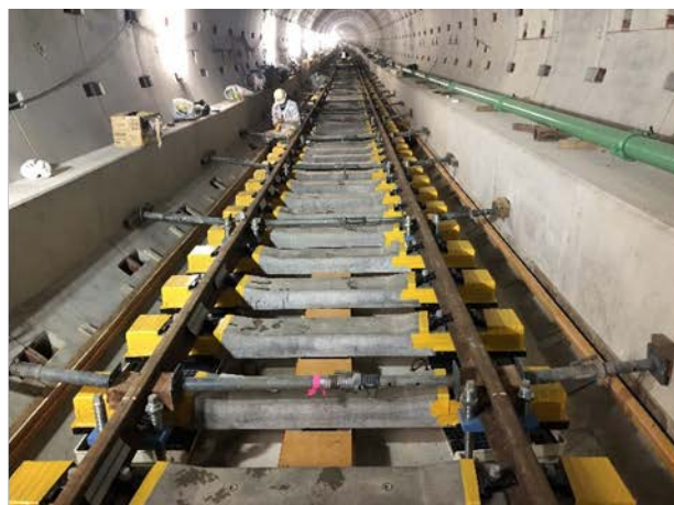
②軌道工事・レール組立状況 (東行線・トンネル内)
