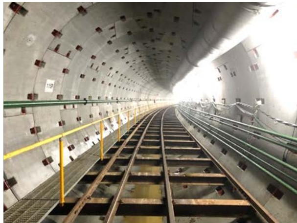
②シールド掘進完了 （西行線・トンネル内）
