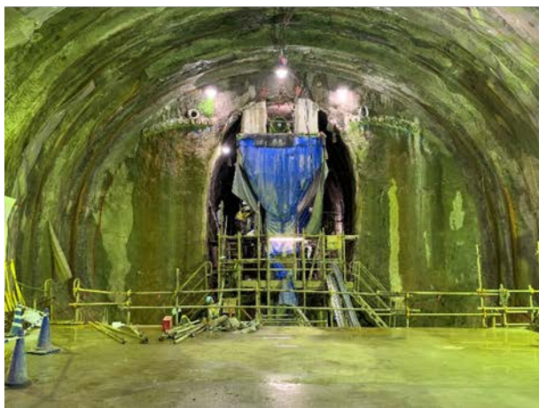
③トンネル掘削前の準備状況（左右坑） （3連トンネル部）
