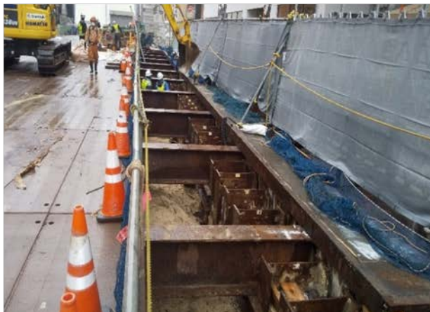
④道路埋戻し状況 (地上部・車道規制帯内)
