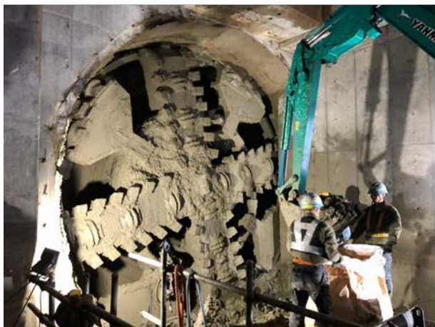
③シールドマシン到達状況 （西行線・到達坑口部）
