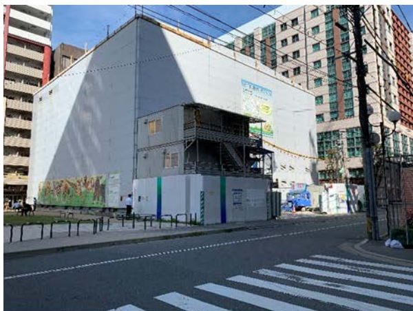
①防音ハウス （明治公園内）
