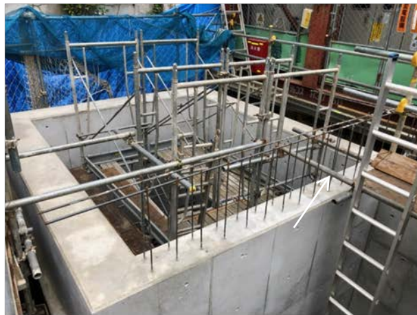
④駅出入口の構築状況 （博多駅側出入口：エレベーター部）
