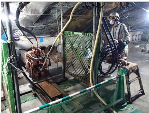
③横パイプルーフ施工状況 （3連トンネル部）
