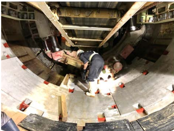
③シールド掘進に伴うセグメント組立状況 （西行線・トンネル内）
