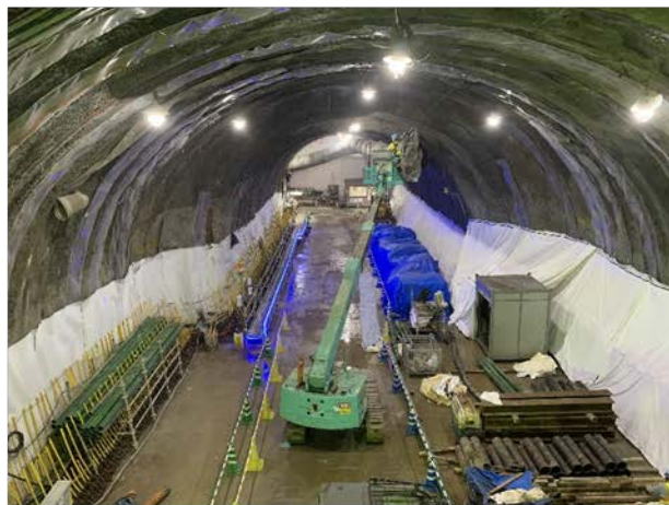
④縦パイプルーフ施工状況 （3連トンネル部）
