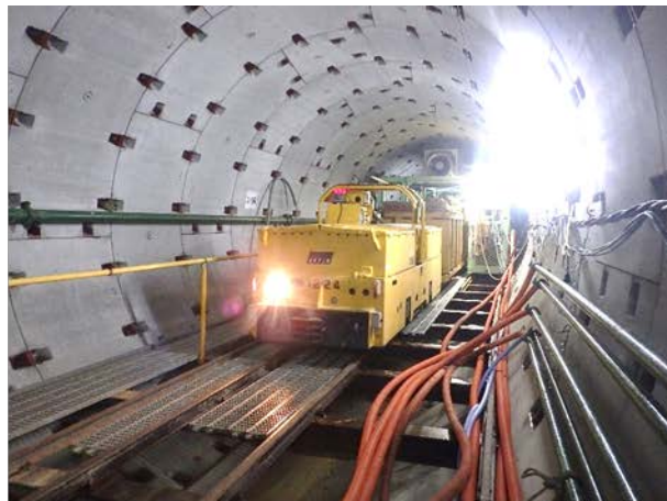
②シールド掘進に伴う土砂の搬出状況 （西行線・トンネル内）
