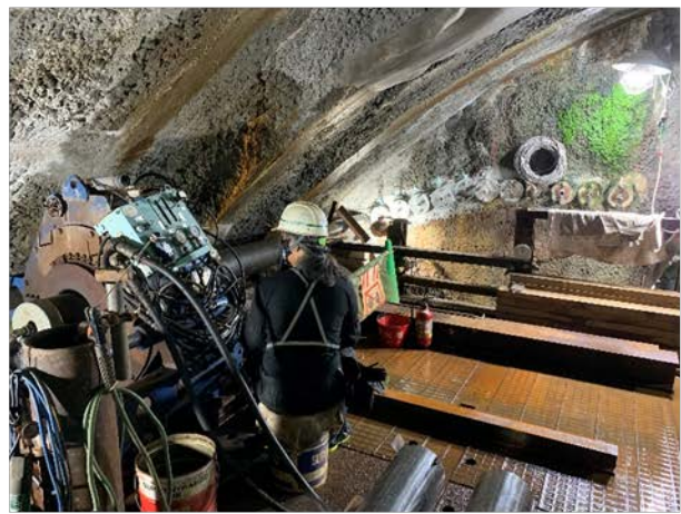
④縦パイプルーフ施工状況 （3連トンネル部）
