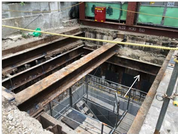
④駅出入口の構築状況（路面覆工撤去） （博多駅側出入口）
