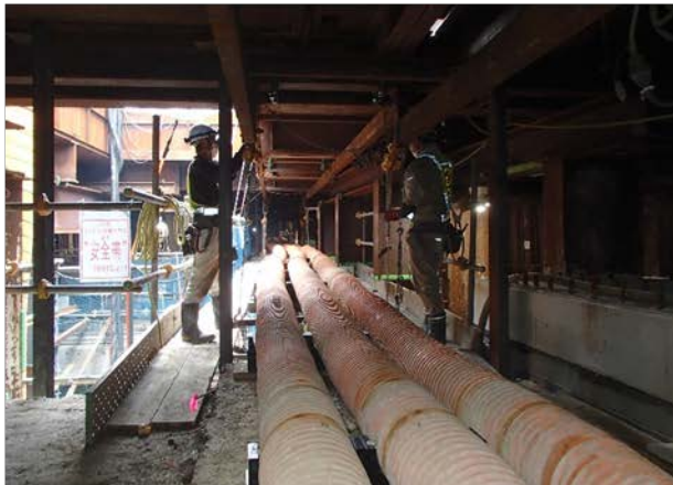
④地下埋設物 (配電管路) の復旧状況 (駅舎部～地上部間)
