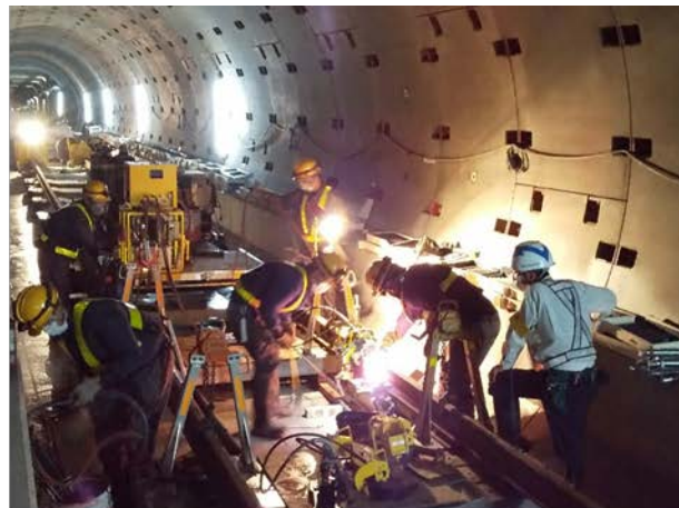
②軌道工事・レール溶接状況 (東行線・トンネル内)
