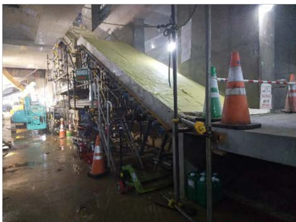
④階段の構築状況 （地下4階・プラットホーム部）
