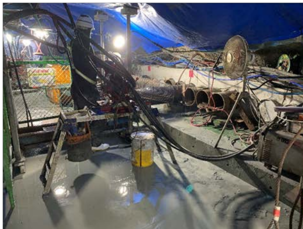
④横パイプルーフ施工状況 （3連トンネル部）
