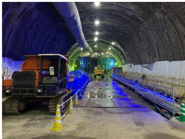
④横パイプルーフ施工状況 （3連トンネル部）
