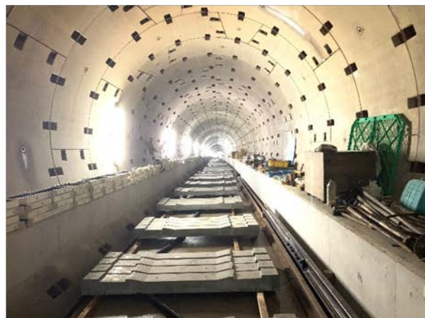
③軌道工事・仮組状況 （東行線）
