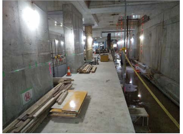
④プラットフォーム等の構築状況 （地下4階）
