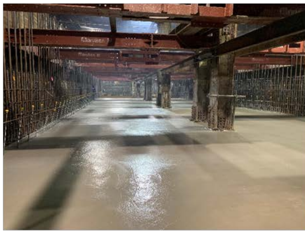
④駅舎部の構築状況 （地下鉄空港線連絡通路）
