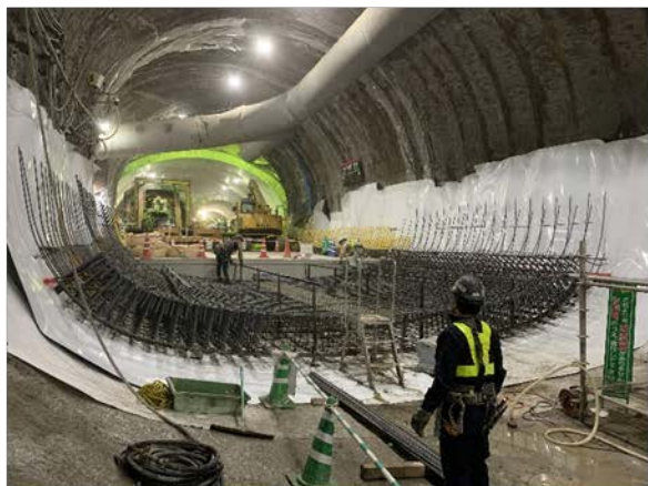
④パイプルーフ施工状況 （3連トンネル部）
