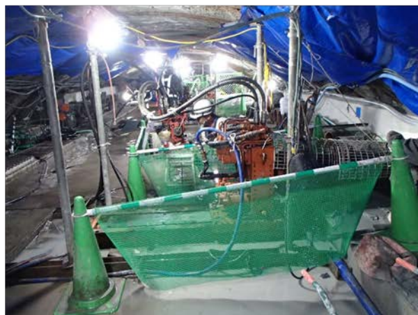
④パイプルーフ施工状況 （3連トンネル部）
