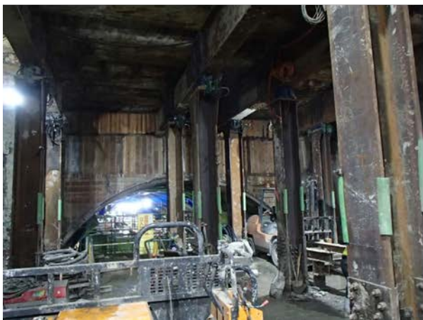
③仮受・掘削状況 （地下車路部）
