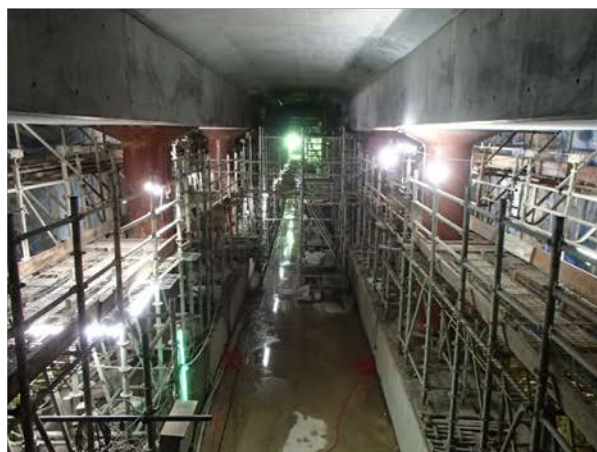
④トンネル構築状況 （3連トンネル部）
