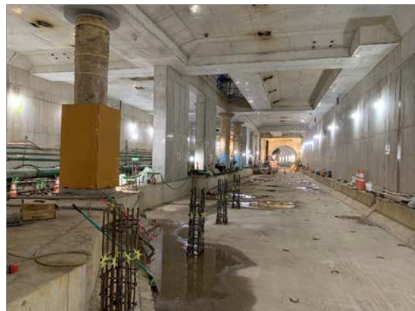
④プラットフォームの構築状況 （地下4階）
