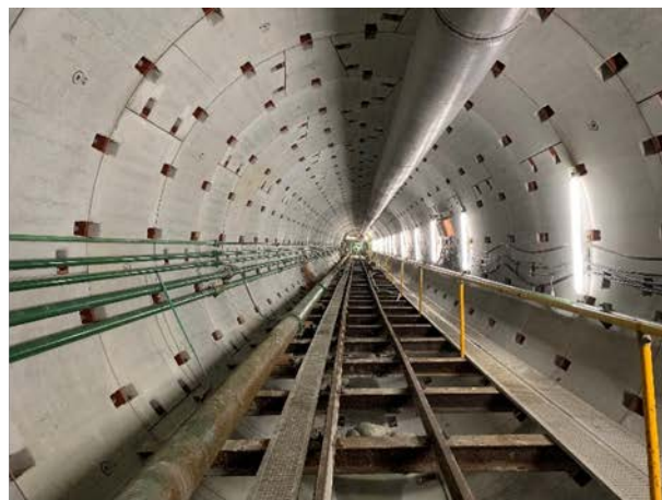
②シールド掘進状況 （西行線・トンネル内）
