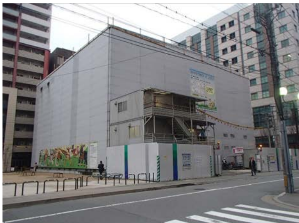
①防音ハウス （明治公園内）
