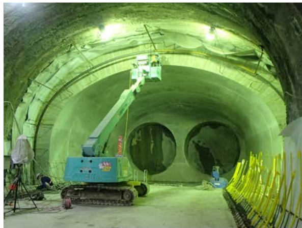
②トンネル構築完了 （大断面トンネル部）
