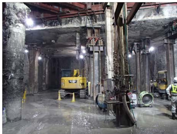
④仮受・掘削状況 （地下鉄空港線部）
