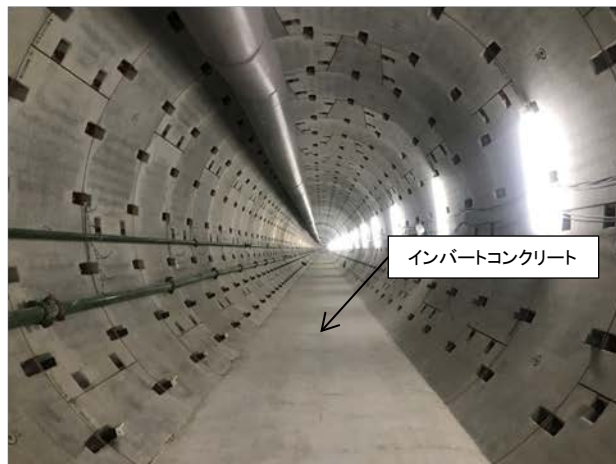
④インバートコンクリート施工完了（東行線）
