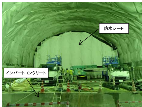
②トンネル覆工状況 （大断面部）
