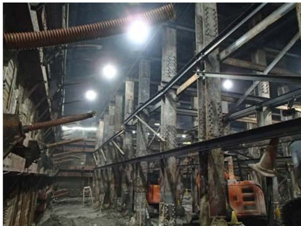
④仮受・掘削状況 （地下鉄空港線部）
