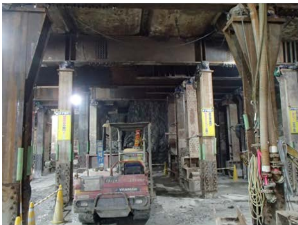
③仮受・掘削状況 （地下車路部）
