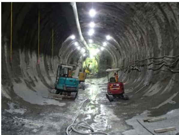
③トンネル掘削状況 （標準トンネル I 型・II 型部）
