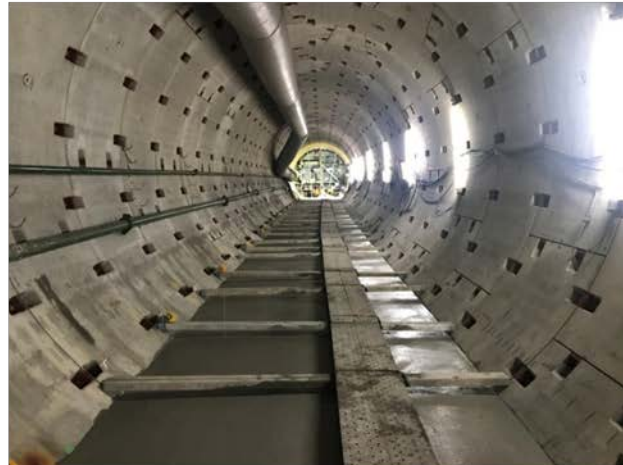
④インバートコンクリート施工状況 (東行線)
