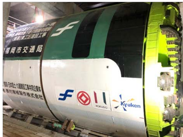
④シールドマシン組立状況 （東行線）
