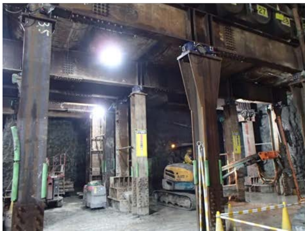
③仮受・掘削状況 （地下車路部）
