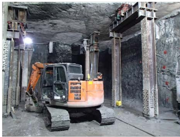
④仮受・掘削状況 （地下鉄空港線部）
