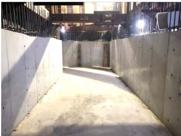
③駅出入口の施工状況 （博多駅側出入口）
