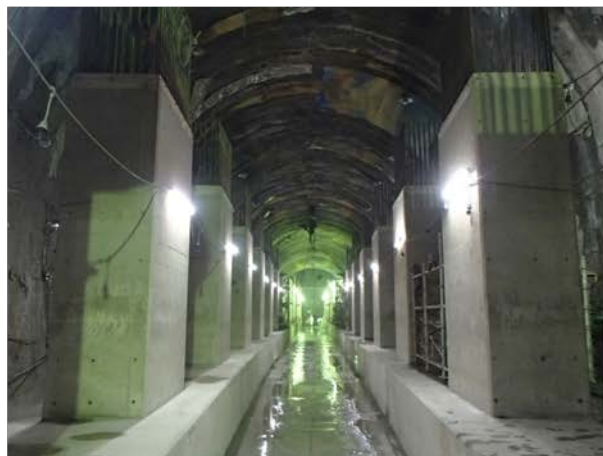
④堆積土砂撤去完了 （3連トンネル部）
