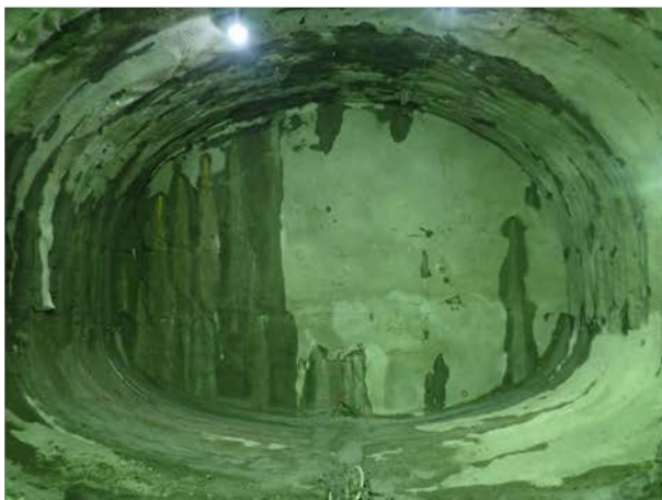
③トンネル部掘削状況 （大断面部）
