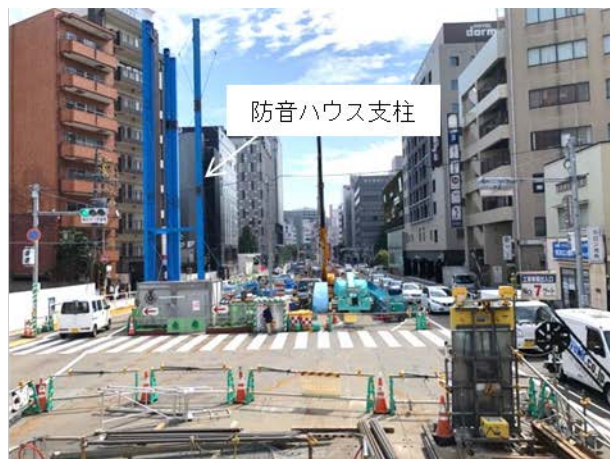
②はかた駅前通りの占用状況 （祇園町西交差点側より）
