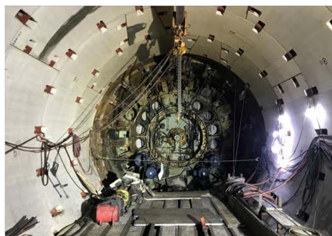
④シールドマシン解体状況 （東行線）
