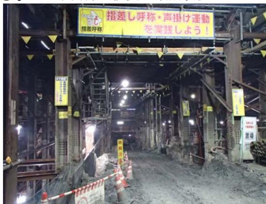
③空港線連絡通路部の仮受・掘削状況
