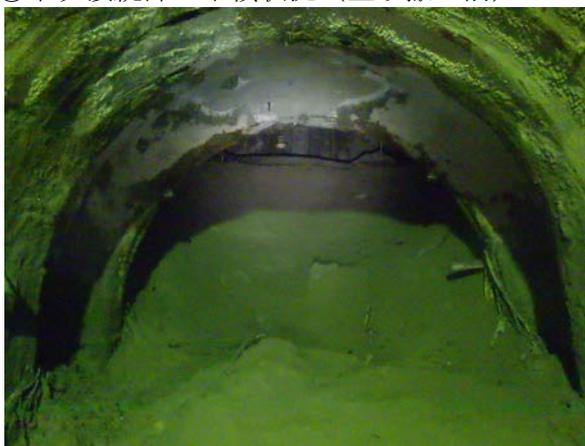
④本坑接続部の施工状況（土砂撤去後）
