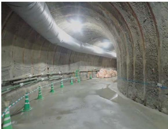
③本坑接続部の堆積状況（土砂撤去前）
