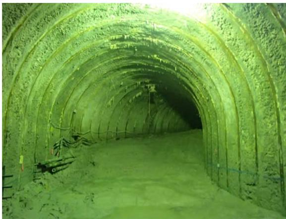
②連絡坑部の施工状況（土砂撤去後）
