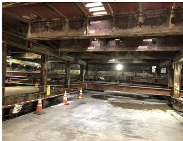
中間駅（仮称）と天神南駅をつなぐ地下トンネルをつくるため、西工区の地下4階から発進したシールドマシンが地下を掘り進めています。また、将来駅舎となる部分のうち、地下3階までの構築が完了し、現在は地下1、2階の施工を行っています。
