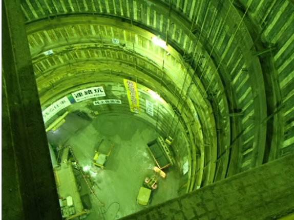
①堆積土砂の撤去状況（立坑部）
