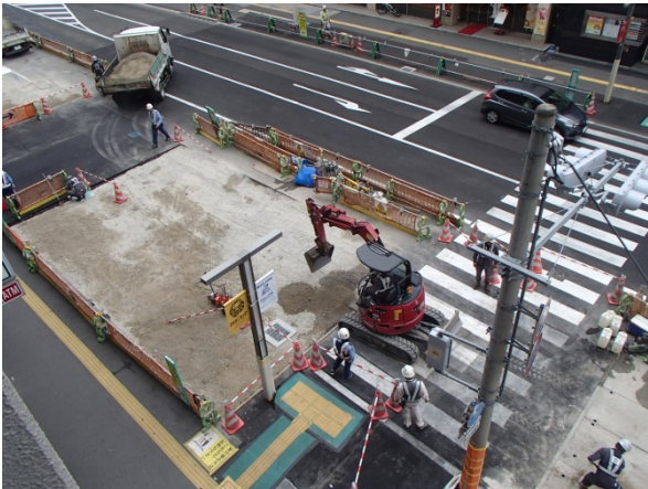
③覆工板の撤去状況（南側占用帯）
