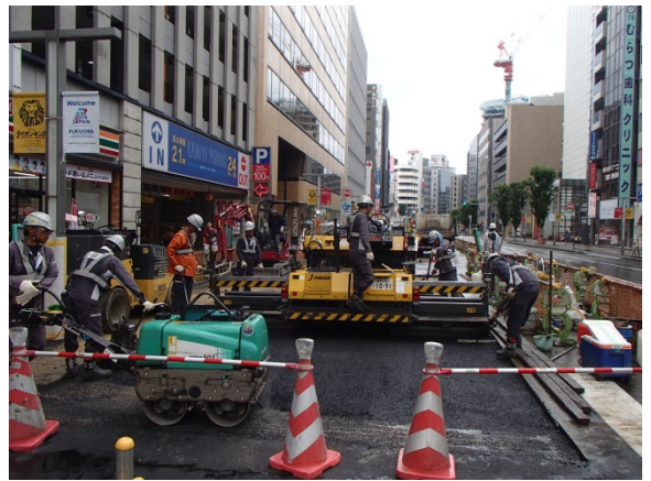
④舗装工の施工状況（南側占用帯）
