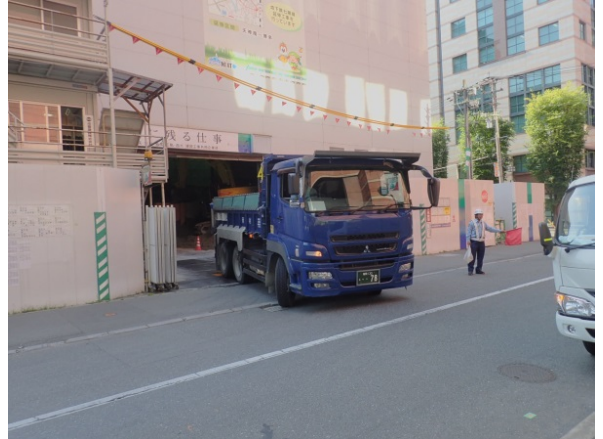
②堆積土砂の搬出状況（防音ハウス部）
