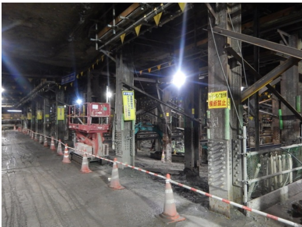
① J R 地下街部の掘削状況
