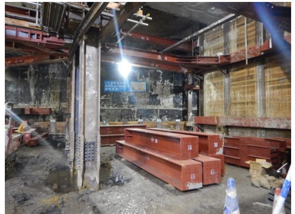
② 空港線連絡通路部の仮受状況
