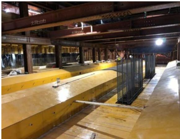
中間駅 (仮称) と天神南駅をつなぐ地下トンネルをつくるため、西工区の地下4層階からシールドマシンが発進しました。また、将来駅舎となる部分のうち、地下3層階までの構築が概ね完了し、現在は地下1, 2層階の施工を行っています。
