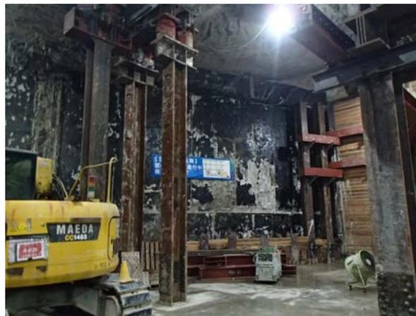
アンダーピニング工法を用いて、JR地下街等の既設構造物を仮受杭にて支えながら、地下の掘削を行っています。
