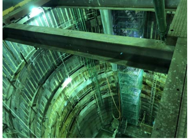
④覆工板の撤去状況
