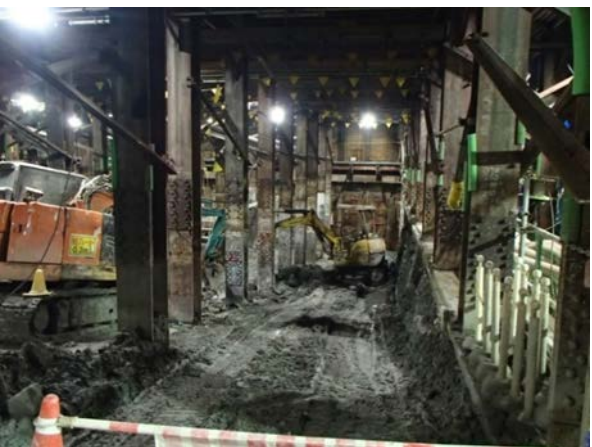
①JR地下街部の掘削状況
