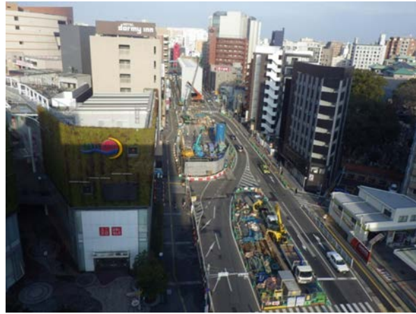
④駅舎の施工状況 〈中間駅西工区：地下2層階〉
