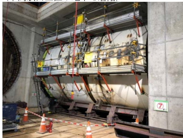
⑤シールドマシンの組み立て状況 〈中間駅西工区：地下4層階〉
