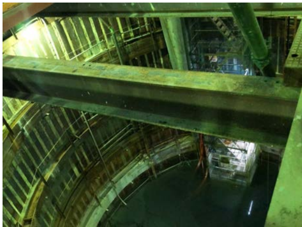
①トンネル坑内の水抜き状況（立坑部：1月）
