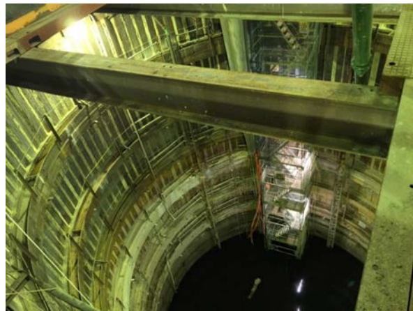
②トンネル坑内の水抜き状況（立坑部：2月）
