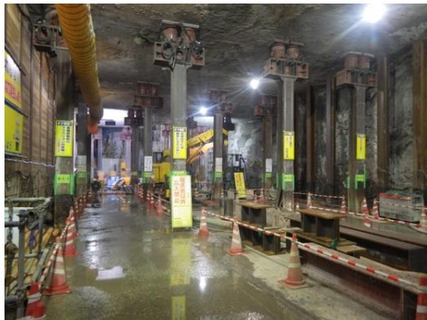
アンダーピニング工法を用いて、JR地下街等の既設構造物を仮受杭にて支えながら、地下の掘削を行っています。
