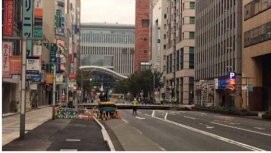
今朝5時15分頃、博多駅前2丁目交差点付近で道路陥没事故が発生しました。現在、博多交差点から博多区役所南口交差点の区間において全面通行止めとしています。お怪我をされた方はおられません。原因については調査中です。他の地下工事区間でも同じような可能性がないか工事業者には緊急点検を指示しています。2次被害対策でガスはすでに遮断作業中。爆発などの危険性のある中圧ガスは遮断完了。あとは細い枝葉の管である低圧ガスを遮断するよう現在作業中です。
