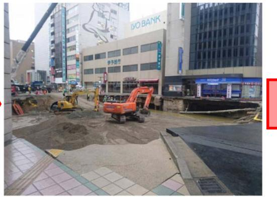
【陥没発生3日目】10日15時投稿。地盤となるセメント混合土は昨日無事投入が終わり、固まり具合を確認して、現在は碎石による表面の埋め戻し作業中とのことです。今後の流れについて、現場に確認したことを含めて共有しますね。
