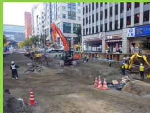
[砕石埋戻し・路盤工]
