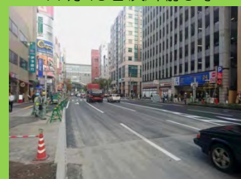
[道路仮復旧の完了] 11月15日(火)午前5時
