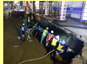
[近隣ビル基礎周辺の充填]
