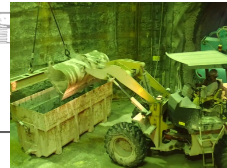
立坑下 ずり積込み・揚重
