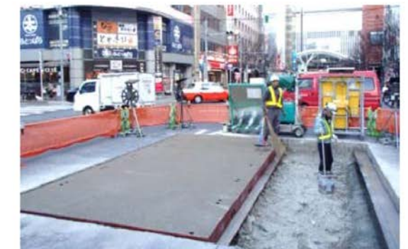
(写真2 路面覆工設置作業)
