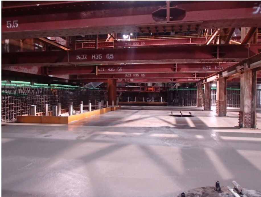
＜コンクリート打設完了＞
