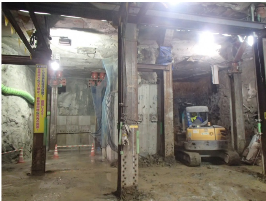
<導坑掘削の状況>
