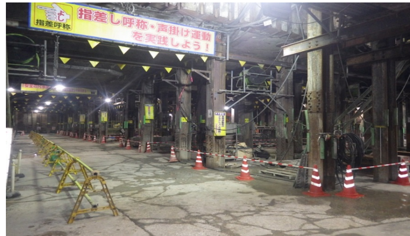
<仮受杭の設置完了>
