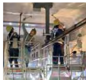
構造物打音検査
