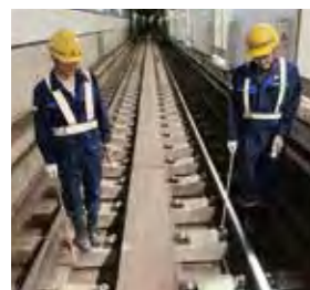
トンネル巡視
