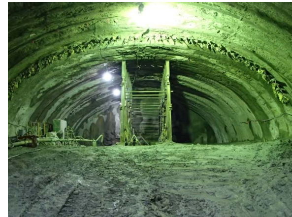
上半部掘削完了 (8月27日)
