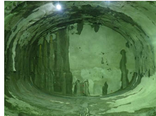
掘削完了 (9月26日)
