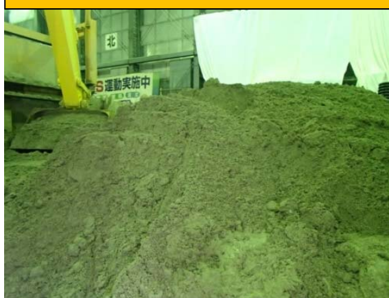
明治公園立坑土砂ピットの堆積土砂
