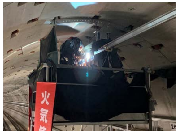
▲ 電車線溶接作業の状況 <シールド区間>
