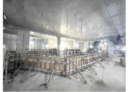
▲ 間仕切り壁設置工事の状況 <博多駅>
