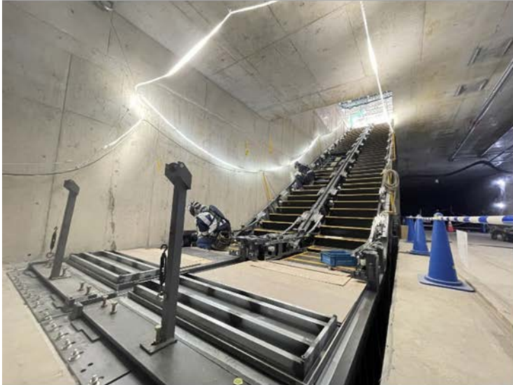
▲ エスカレーターの設置状況 <櫛田神社前駅>
