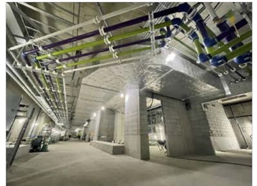
▲ 設備配管の敷設状況 <櫛田神社前駅>
