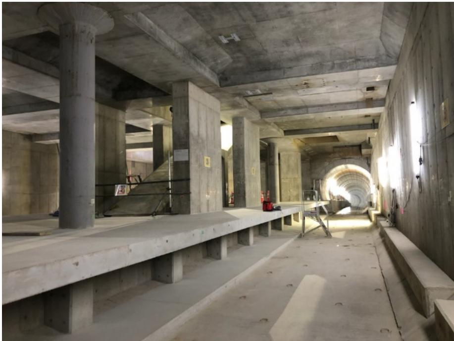
①フラットホーム・階段の構築完了 <地下4階>
