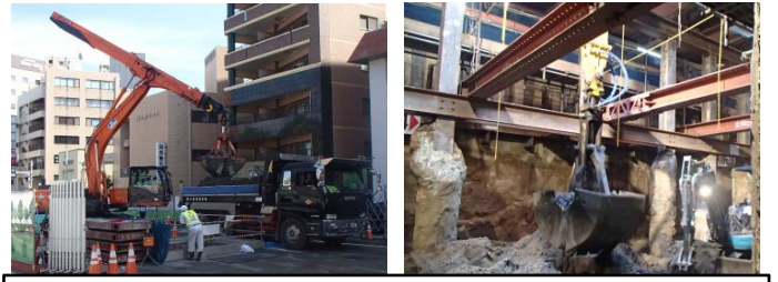
■テレスコラムを使って、地下の深い部分を掘削しています。
