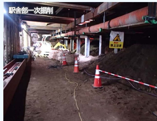
写真④：掘削状況（東工区）
