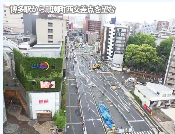
写真③：はかた駅前通り占用状況（東工区）
