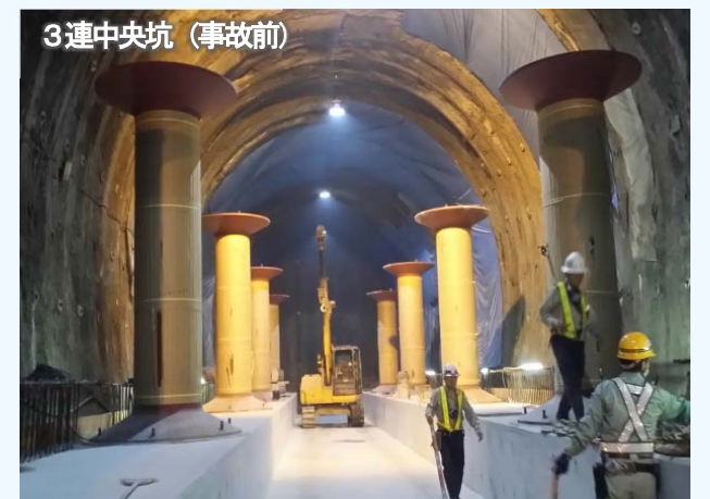
写真④：躯体構築状況
