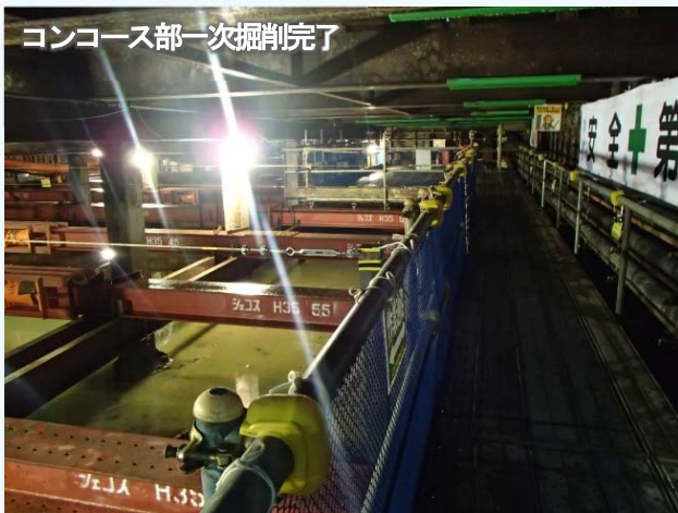
写真②：掘削状況（西工区）
