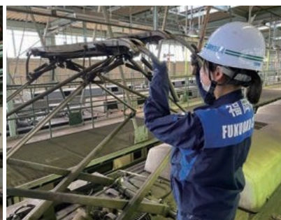
パンタグラフ点検
