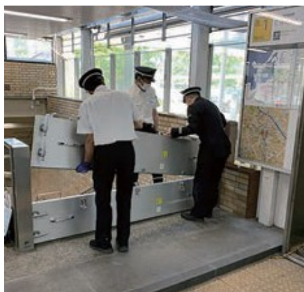
止水板設置訓練
