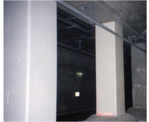
耐震補強後の中柱
