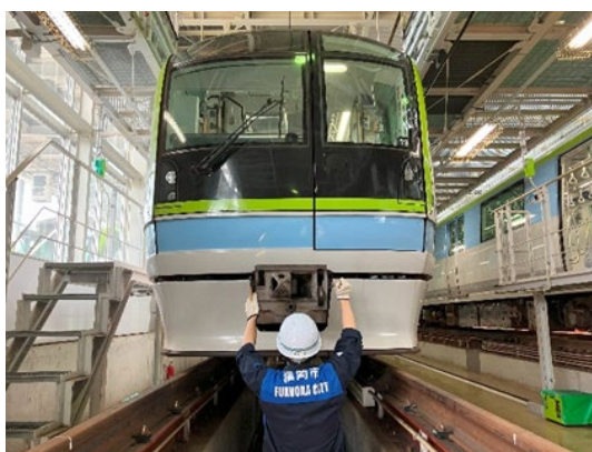
連結器の点検
