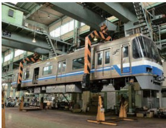
車両基地内での点検風景
