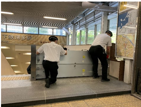
止水板設置の様子
