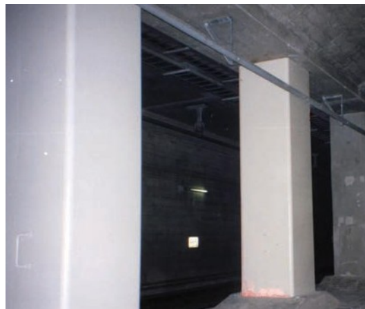
耐震補強後の中柱
