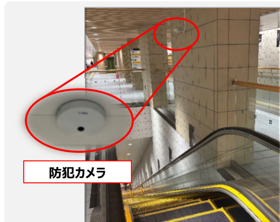
駅構内防犯カメラ
