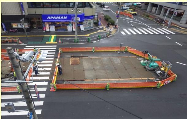
写真2 地盤改良状況(路面覆工状況)
