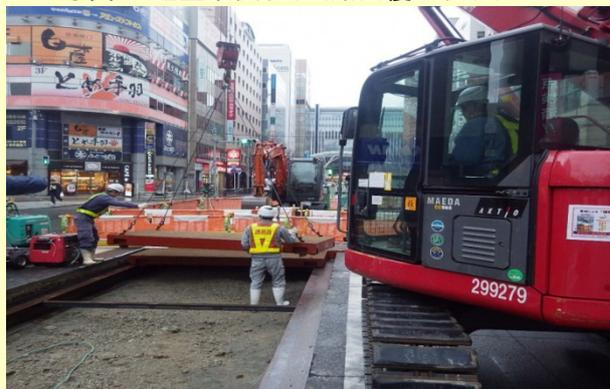
はかた駅前通りを占用し、車線規制を行いながら、トンネル坑内の水抜き・土砂撤去、及び再掘削を安全に行うための地盤改良工事(路面覆工)を実施している。
