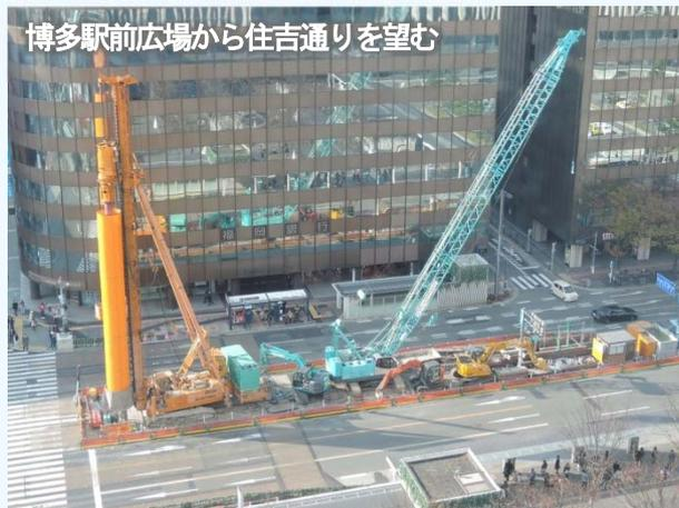
写真④：立坑掘削状況（10月30日撮影）
