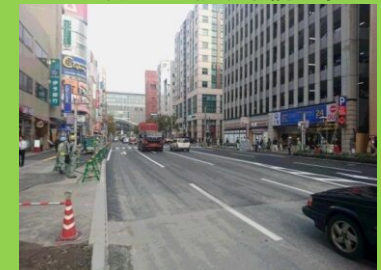
〔道路の復旧完了〕 11月15日（火）午前5時
