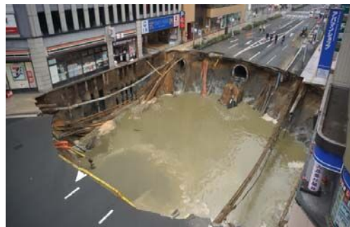
7:20頃 道路中央部陥没
