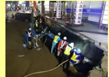
〔近隣ビル基礎周辺の充填〕
