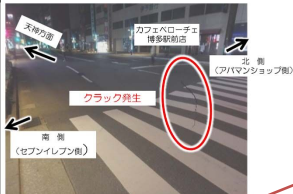
5:15頃 道路陥没(舗装クラック発生)
