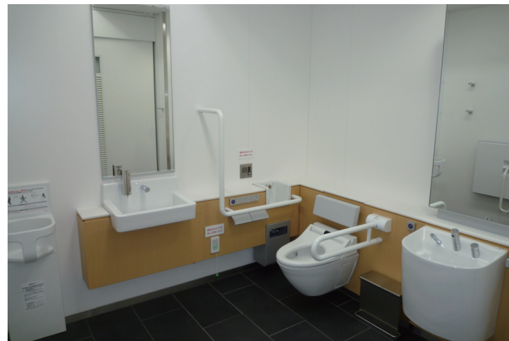
みんなのトイレ/面台の高さを揃えてすっきりとした空間とし、温水の出るオストメイト(*) 対応設備と多目的シートを設置しています。
