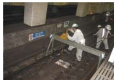
レール交換作業 (必要に応じて保守点検等、 安全管理を徹底)
